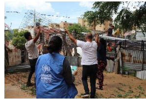
En Riohacha, ACNUR suministró materiales de infraestructura para la construcción de una tienda circular, proyecto comunitario liderado por la Fundación Brisas del Norte. Esta tienda será administrada por miembros de la comunidad, lo que permitirá el acceso a medios de vida, a la vez que promoverá una economía sostenible y el reciclaje de residuos.
