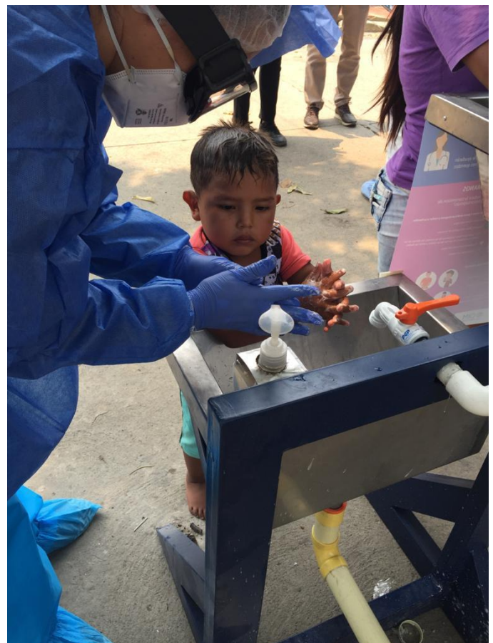
Instalación puntos de lavado de manos para población Yukpa en sector El Escobal © UNICEF
